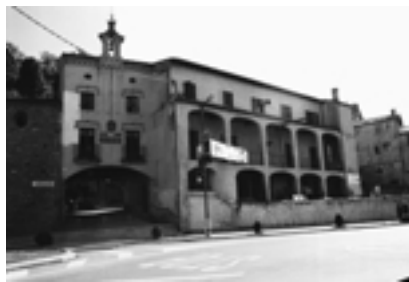
Hospital Vell de Ripoll, futura seu de l'Arxiu Històric Comarcal de Ripoll (foto Servei d'Arxius, 1999).
