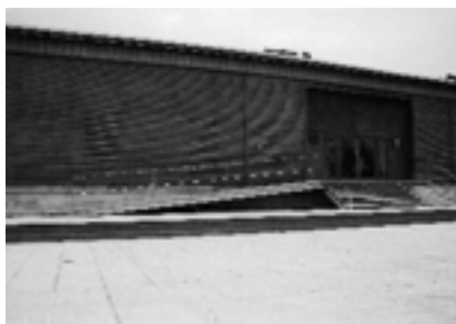
Arxiu Històric Comarcal de Berga. Pavelló de Suècia. Foto: Servei d'Arxius
