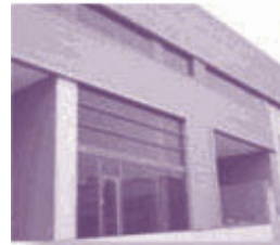
ARXIU CENTRAL ADMINISTRATIU (Sant Just Desvern)
